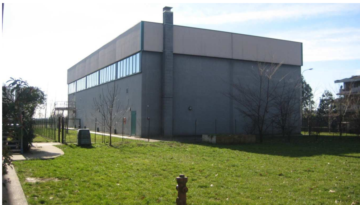
vista esterna dell'edificio
